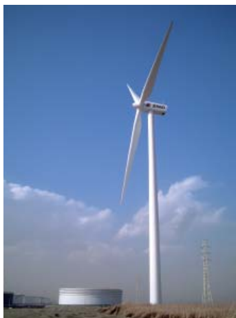
風力発電設備
