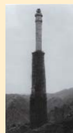
竣工直前の「大煙突」
