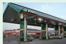
太陽光発電パネル設置 JOMOステーション
